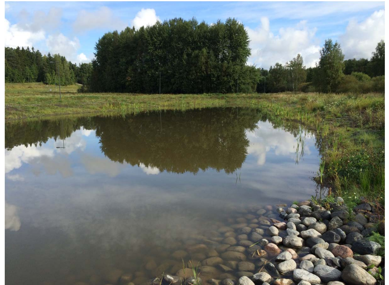
Kuva 11. Referenssikuva hulevesialtaasta Espoon Pellaksenmäessä. Altaassa käytetty eroosiosuojamattoman Greenfinin Covamat plus siemenseroosiomattoa. Altaan pohja on rakennettu murskeesta ja pato luonnonkivistä. (Altaan suunnittelu ja valokuva: Sito Oy)
